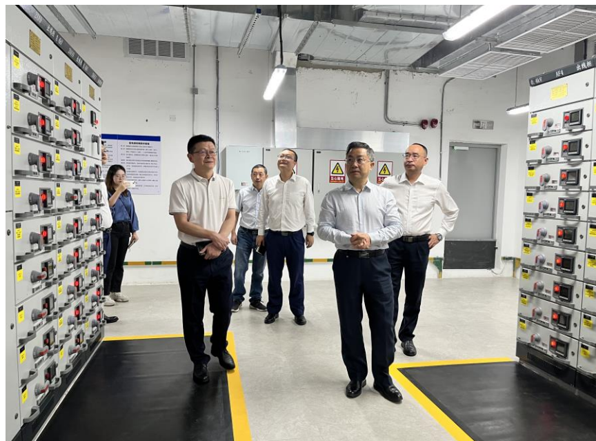
公司领导带队重大事故隐患排查整治行动现场检查
